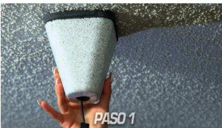
Cubra las cabezales aspiradores. Bed Bug Heat Doctor-PrevSol no es responsable por ningún daño si la cabezal aspirador no está cubierta. Recomendamos el uso de cubierto para el grifo de afuera disponible en cualquiera tienda de mejoras para el hogar. El cubierto para el grifo de afuera mantiene la cabezal aspirador a 30 grados más frío que la temperatura del cuarto.
